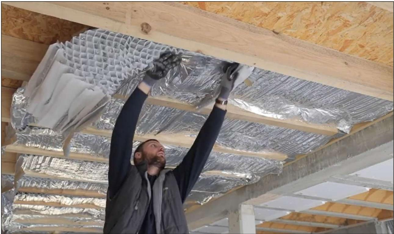
Hier zie je hoe de open ruimte tussen de balken wordt opgevuld met de op maat afgesneden Hybris panelen. Twee opeenvolgende stroken goed tegen elkaar laten aansluiten. Ook valt op te merken dat de panelen zijdelinks goed knellen tussen de balken zodat ze dus ook geen open ruimten of spleten achterlaten.
