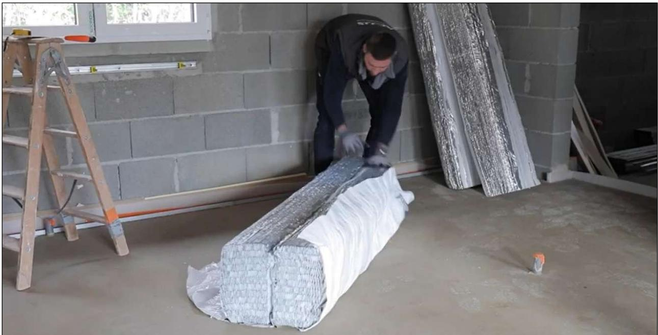
De samengedrukte Hybris panelen zijn hier bijna ontdaan van hun verpakking. Tegen de muur staan reeds twee andere losse panelen, klaar voor gebruik.
