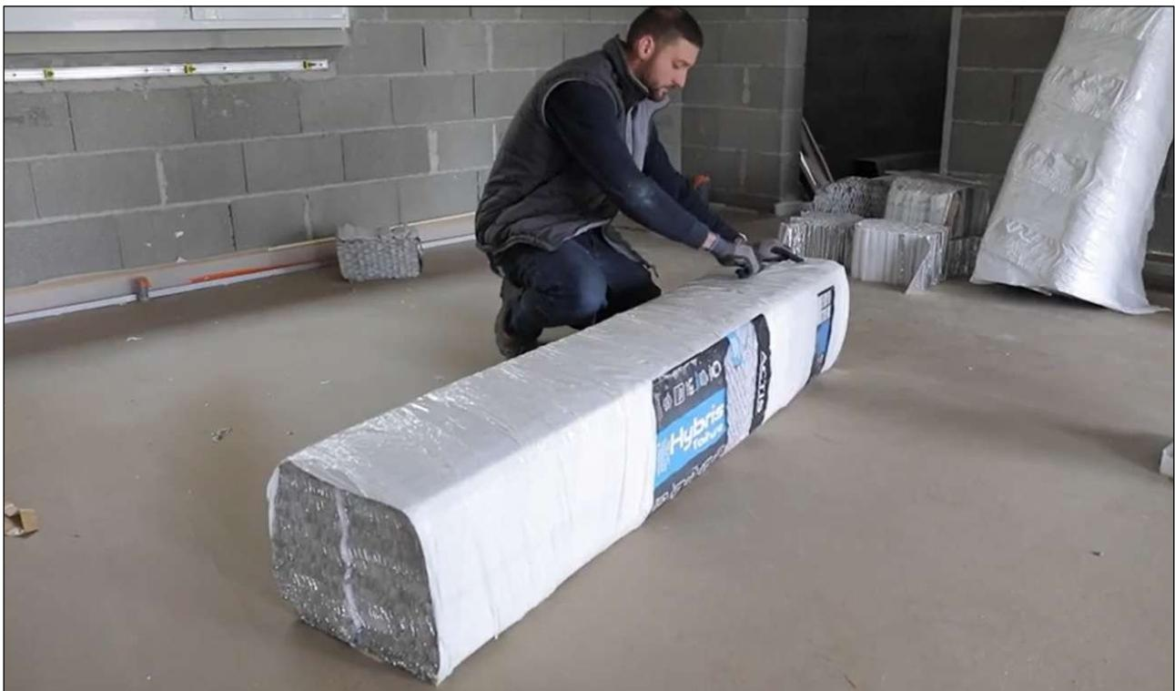
De plastic verpakking wordt gedeeltelijk of geheel verwijderd, met een Prof. cutter, van de samengeperste panelen. Door gebruik te maken van deze cutter wordt de Hybris isolatie niet beschadigd.
