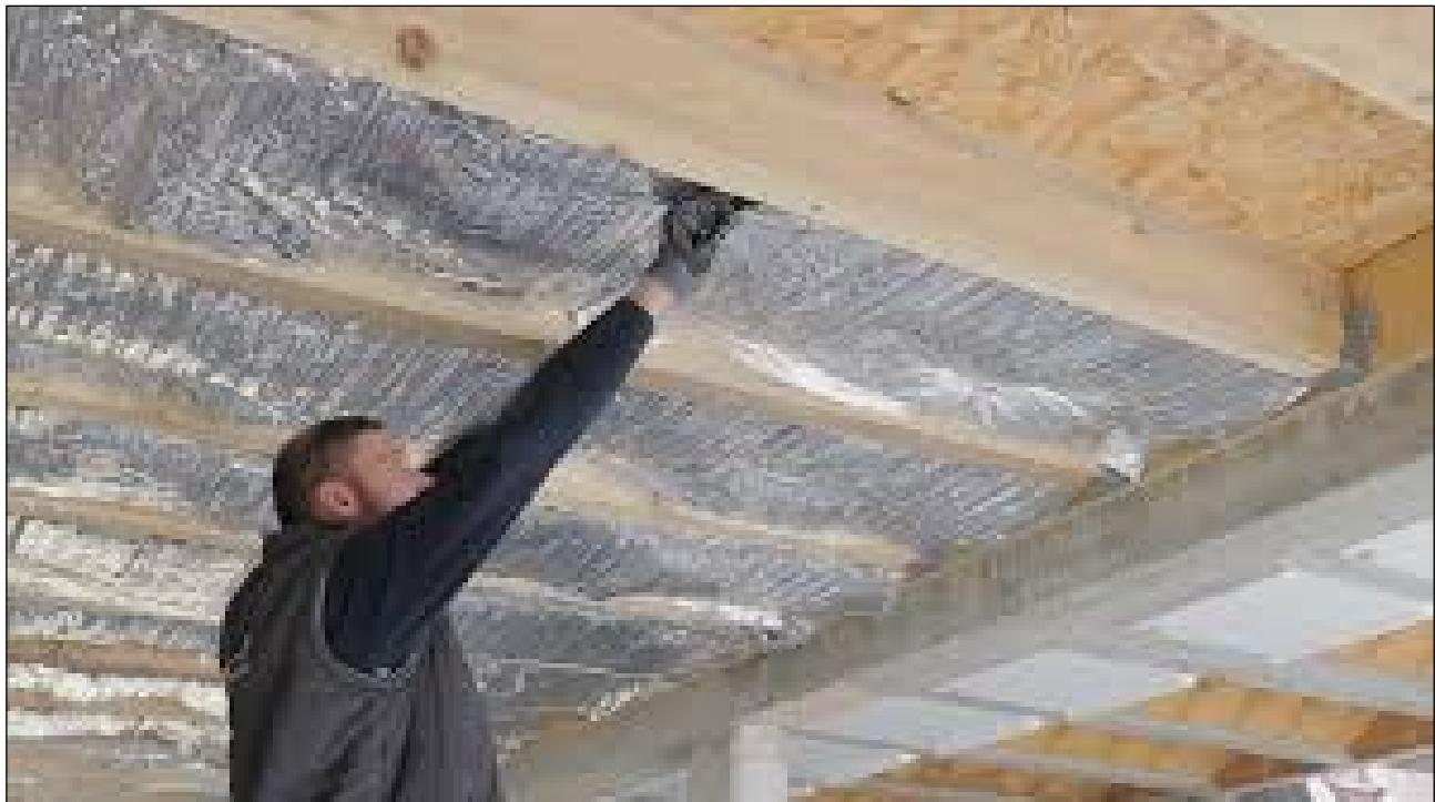
Hier worden de isolatiepanelen aan elkaar verbonden met de geïntegreerde overlappendstrook met kleefstrip, dat in veel gevallen de klassieke Tapes kan vervangen. Vervolgens wordt, over de balken heen, de isolatie met Tapes-O aan elkaar verbonden, terwijl de perifere boorden met Tape-P worden afgesloten. Je zou de Tapes (= kleefbanden) ook kunnen vervangen door over het geheel een dampscherm aan te brengen.
